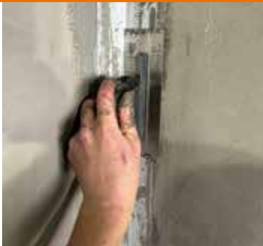
5. Dichtbänder in den Ecken einlegen
