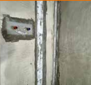
6. Dichtmanschetten einlegen
