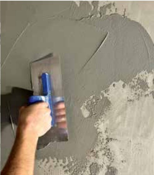
3. Kratzschicht bei porösen Untergründen mit HERKULES 1 K Dichtschlämme
