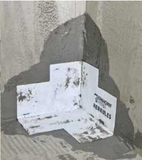
4. Dichtecken in HERKULES 1 K Dichtschlämme einlegen
