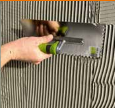
7. HERKULES 1 K Dichtschlämme mit 4 mm Zahnung auftragen
