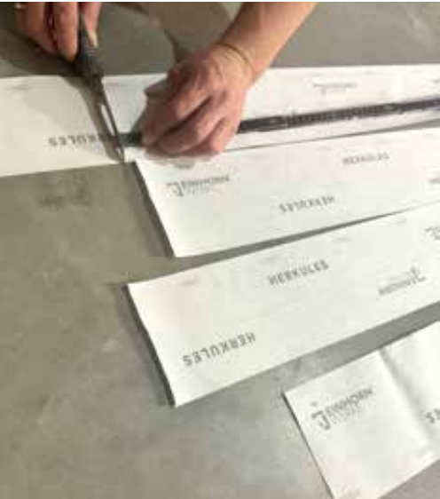
2. Dichtbahnen und Dichtbänder auf Maß zurecht schneiden
