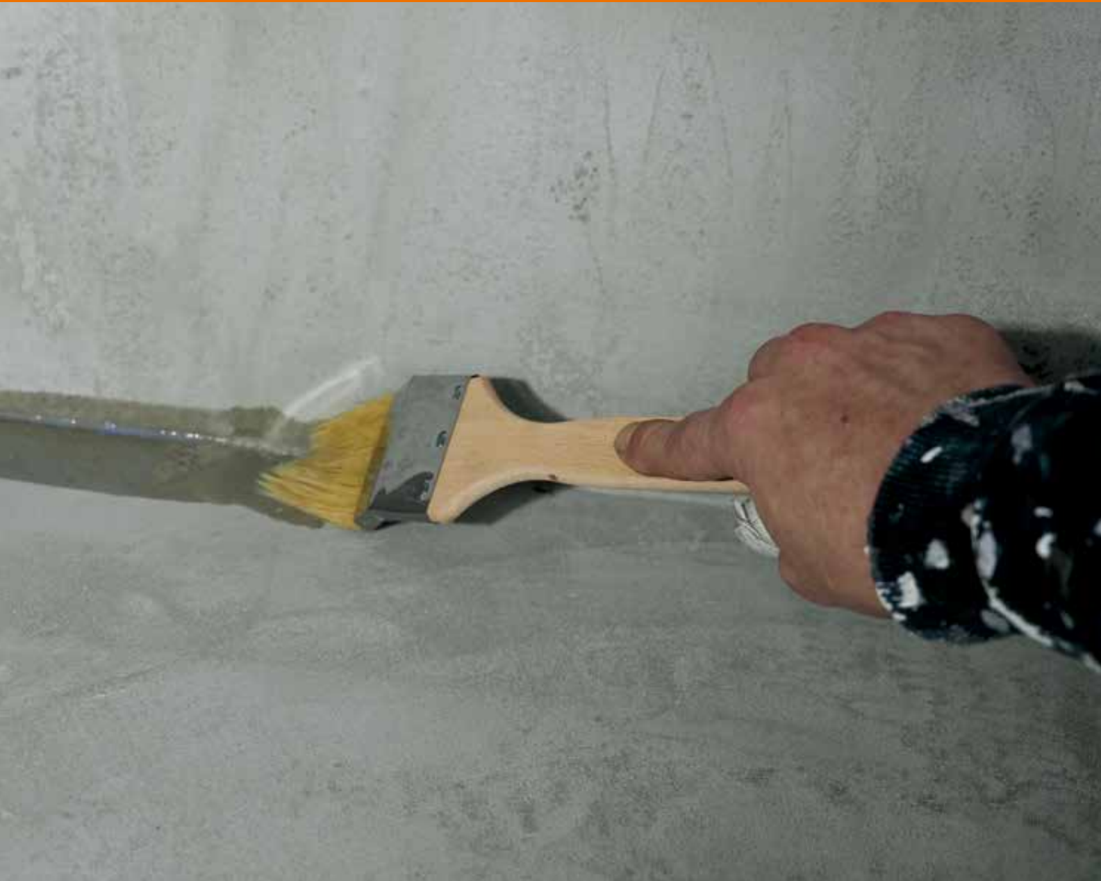
1. Grundieren mit EINHORN WERKE Tiefgrund
